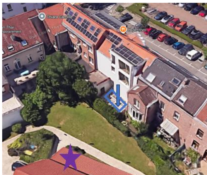
Vue aérienne de l'îlot avec la localisation de l'annexe et de la ferme classée. Photo ©Google Street View avec ajout de la CRMS.
