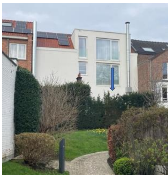
Photo de la façade arrière du bâtiment avec la localisation de l'annexe. Photo extraite du dossier, avec ajout de la CRMS
