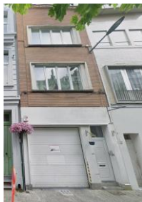
Façade avant situation existante @google maps
