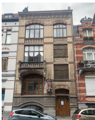
Façade à rue (© Urban – DPC)
